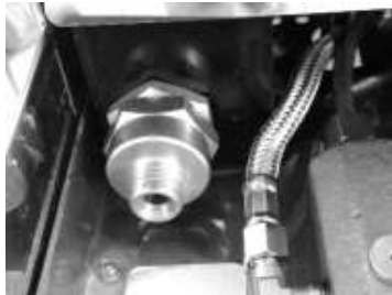
Wasseranschluss Festwasser 3/8"
